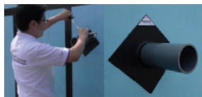
気密部材の施工事例
