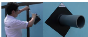
気密部材の施工事例
